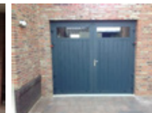
Horizontaal geplaatste glasstrook in verticaal geprofileerde deur
