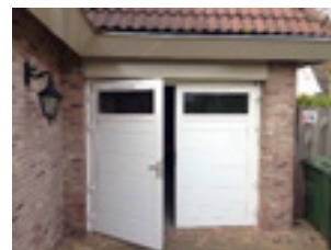
Horizontaal geplaatste glasstrook
